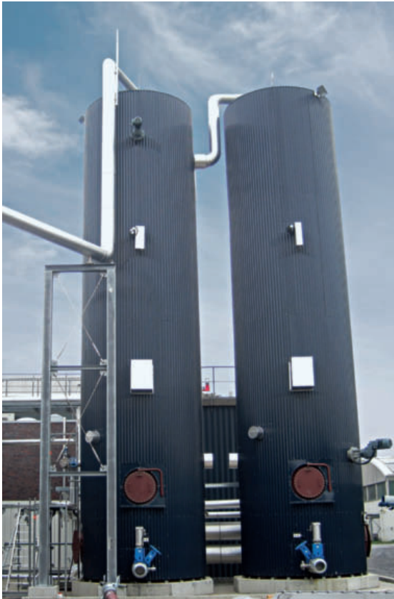
▲ Core of the new technology is a biofilm fermenter Kern der neuen Technologie ist ein Biofilmfermenter
