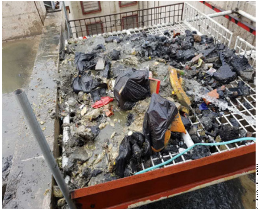
▲ 3 Sewage sludge from channels close to digestion tanks Abfall aus Kanälen in der Nähe von Faultürmen
